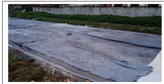
Gambar 3.9 proses Curing Beton Bekerjasama dengan Pusjatan Kemen PUPR
